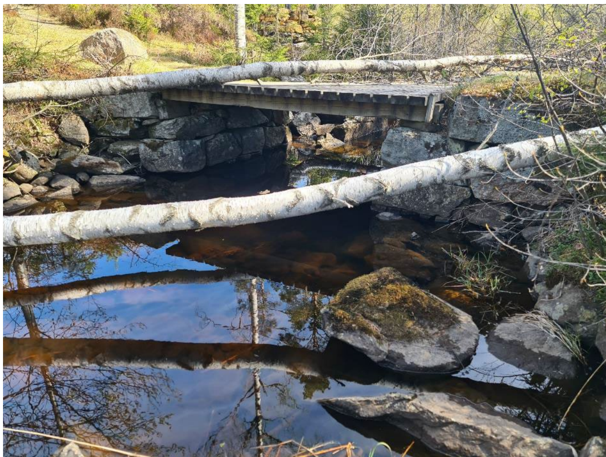
Figur 6. Utloppet ur Stora Ulvattnet med resterna efter en flottningsdamm. Utloppet ligger på gränslinjen mellan Sverige och Norge.
