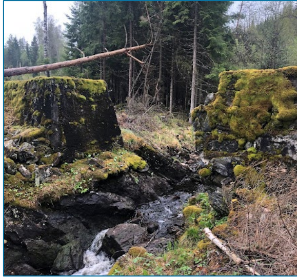
Bilde 2. Rester av damanlegg oppstrøm brua (Foto: Johan Bergerud).
