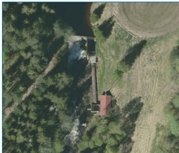
Bilde 1. Flyfoto av kraftverksdam i Oselva (Kilde: NIBIO, Kilden)
